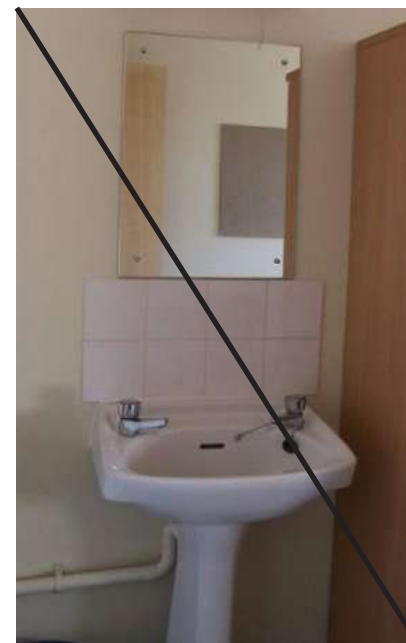
Плохо Раковина с пьедесталом. Фартук из плитки
